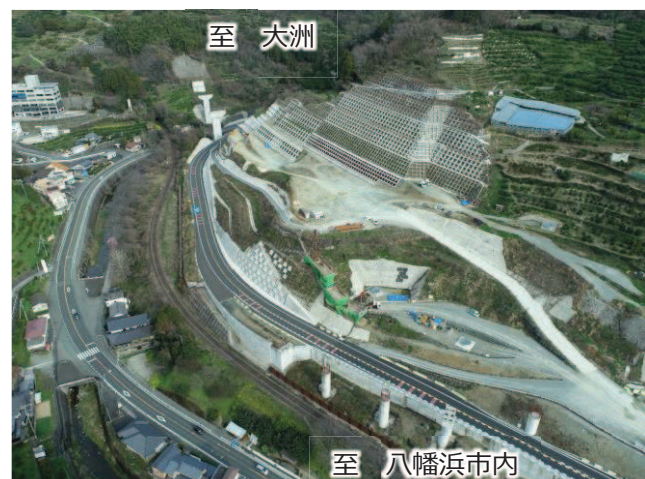
【整備状況】大洲・八幡浜自動車道〔夜昼道路〕(八幡浜市)
