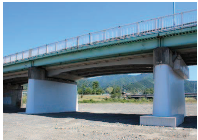
【施工事例（橋梁耐震補強）】一般県道 松山川内線（東温市） 〔橋脚巻立工〕
