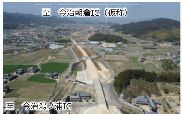
今治道路 工事状況 (今治市) 写真提供：国土交通省
