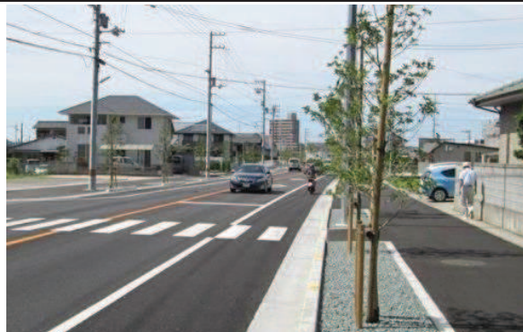
【施工事例】都市計画道路 西町中村線 (新居浜市)
