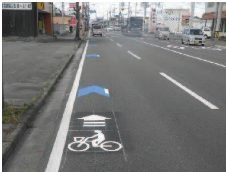
【施工事例（路面標示による自転車通行位置の明示）】 主要地方道 壬生川新居浜野田線（新居浜市）
