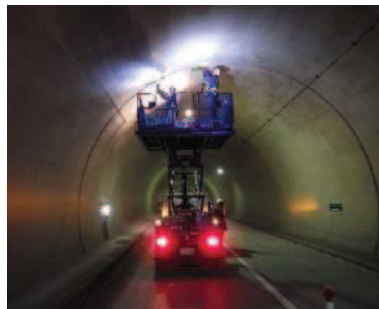
【トンネル定期点検(地芳トンネル)】 一般国道440号(久万高原町)
