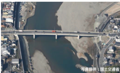
【肱川橋橋梁架替】 一般国道56号(大洲市大洲～中村)
