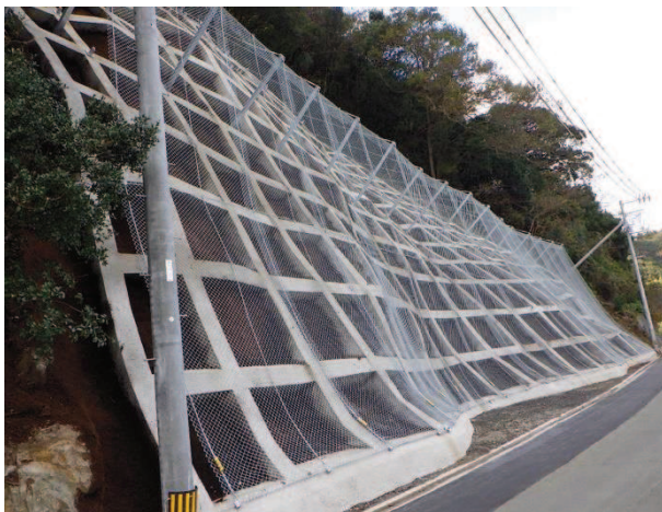
【施工事例（法面防災）】一般国道378号（八幡浜市） 〔法枠工+ロックネット〕
