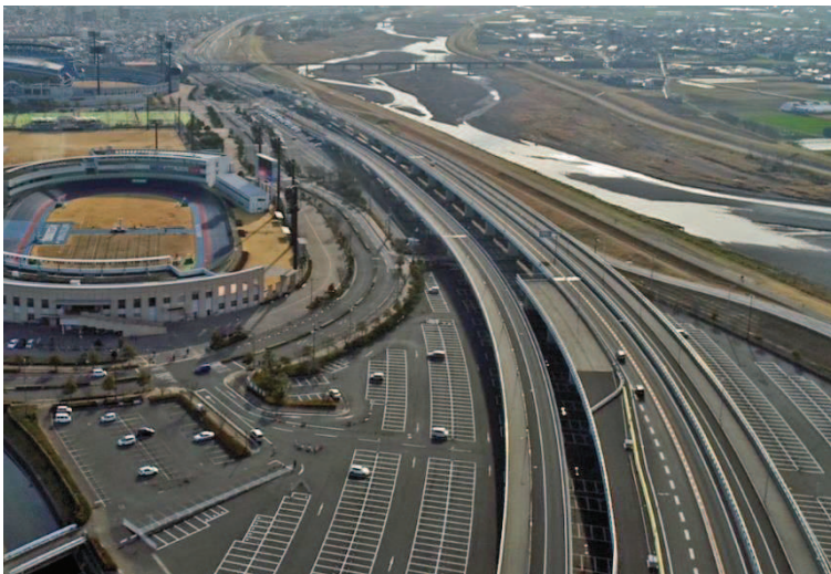
【施工事例】松山外環状道路（インター線）
