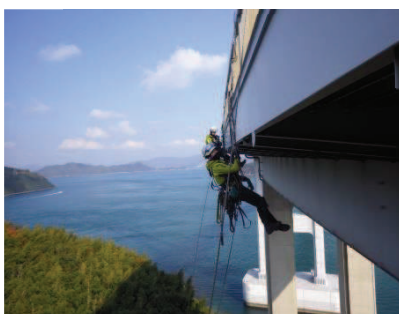
【橋梁定期点検(小浦高架橋歩道橋)】 一般県道 今治大三島自転車道線(今治市)
