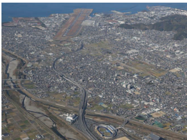
松山外環状道路〔空港線〕(松山市) 写真提供：国土交通省
