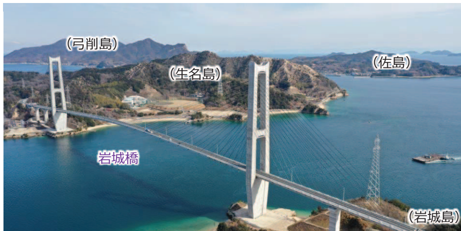
一般県道岩城弓削線〔岩城橋〕令和4年3月開通（上島町）
