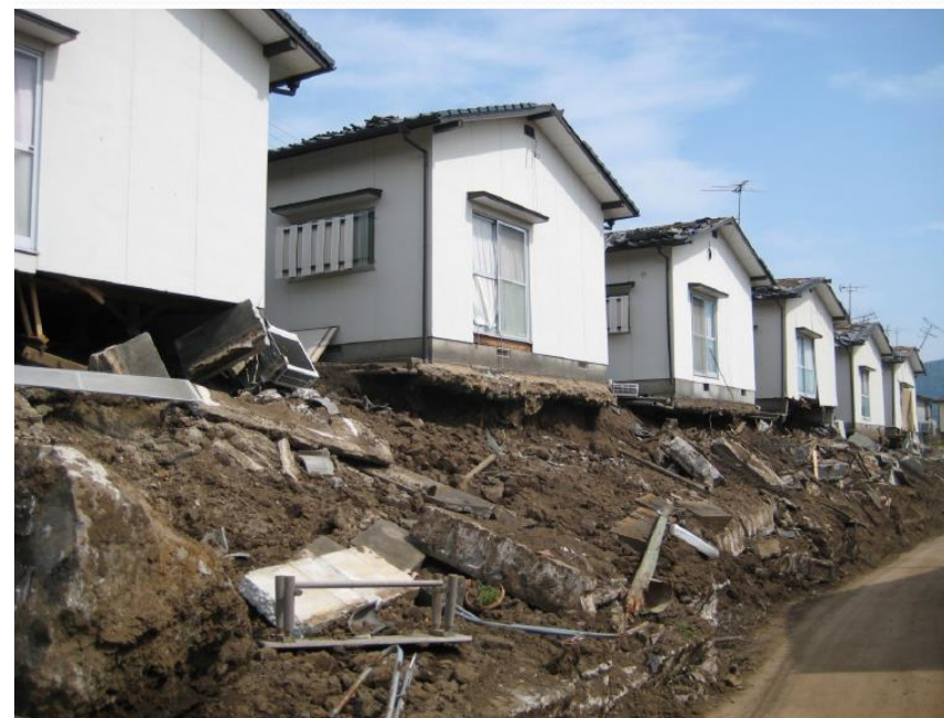
H28熊本地震の被害
