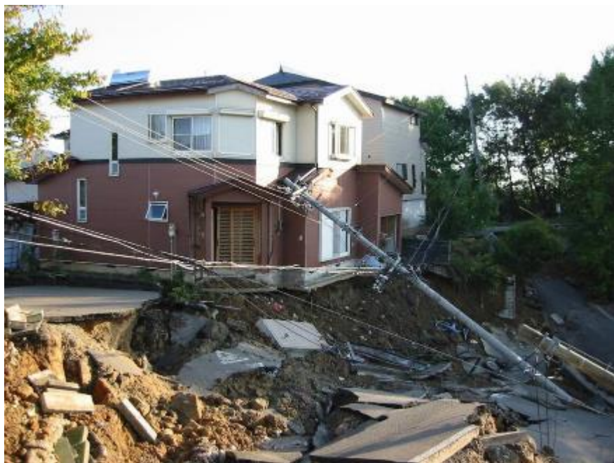
H16新潟県中越地震の被害
