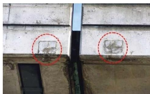
写真 2.4 ひび割れ、漏水 (定着部)
