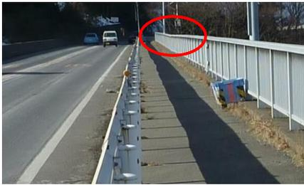
※写真は中央ヒンジを有する橋梁に異常なたわみが生じている事例。
