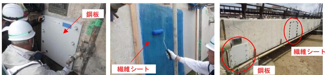
写真 2.3 横締め PC 鋼材の突出防止対策
