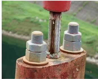
被覆されたハンガーに制震ロープが配置されている例
