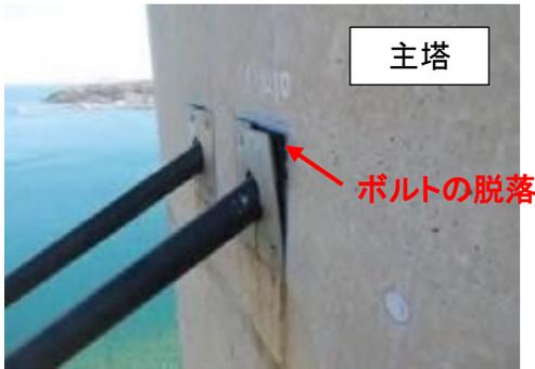
写真は、サドル部保護カバーの損傷事例
