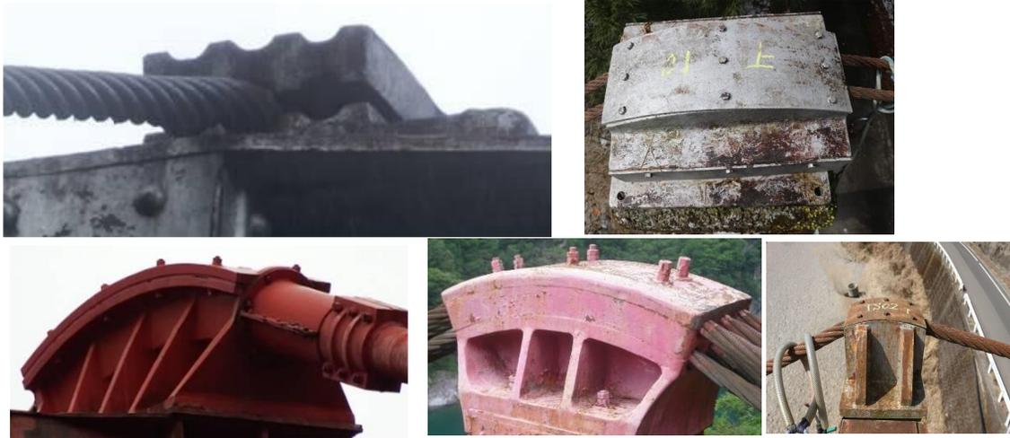
小規模な吊橋では主ケーブル自体の押しつけ力が必要な摩擦力を得るのに不足するため、プレートによって上から締め付けて押しつけ力を補強している場合もある。
