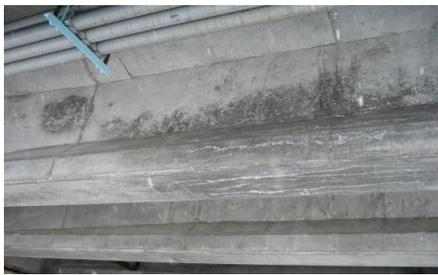
※写真はPC桁下面のひびわれ事例
