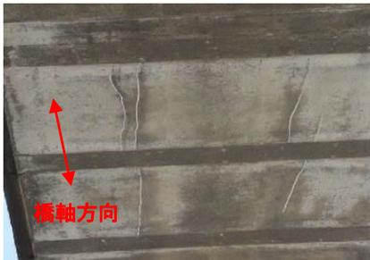
※写真は吊床版橋下面のひびわれ事例
