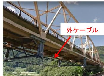
鋼橋の外ケーブル補強の例
