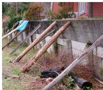
頼杖による擁壁倒壊防護
