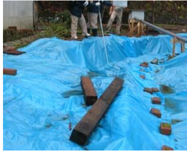
シートによる宅盤亀裂の防護
