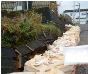
土嚢積みによる擁壁崩壊の抑制
