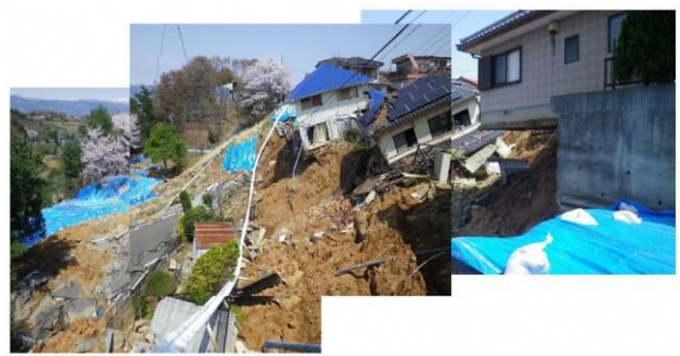
(d) 液状化による側方流動
