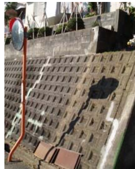
モルタル充填による亀裂の防護
