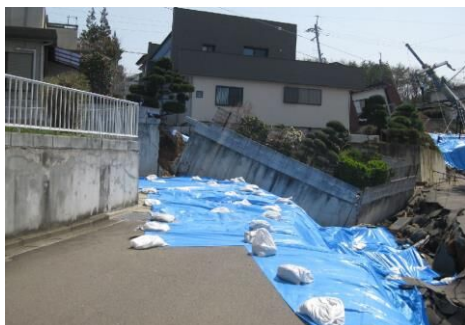
(c) 腹付け盛土の崩壊
