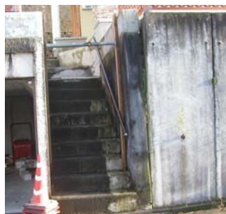
切梁による擁壁変位抑制
