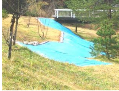
シートによる斜面の防護
