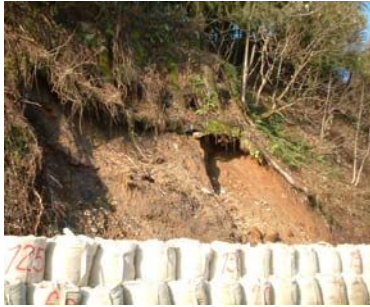
土嚢積みによる斜面の抑制
