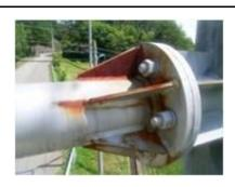
リブやボルトの存在により構造的に 滞水が生じやすい条件の部位がある と、その箇所で顕著に腐食が生じる ことがある。排水勾配や水抜き孔が 設けられていても堆積物や勾配不足 などで滞水が生じることもあるため 注意が必要である。
