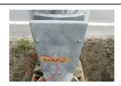
電気設備用開口部ボルトの脱落がある場合,ボルト孔から内部に水が浸入し,内部で滞水,腐食が進行し、支柱の耐荷力に影響が生じている場合もある。また,ボルト孔や開口部の存在に起因する応力集中部からは疲労亀裂が生じやすいことにも注意が必要である。
