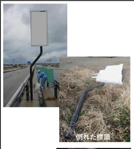
ガードレール支柱に添架した標識 (2点固定)が転倒した例。 ボルトにゆるみが生じ、ボルトに曲 げ応力が作用すると、早期に破断に 至る場合がある。
