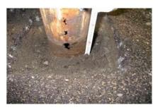
支柱基部では、地中部の湿潤環境や 地下水の影響、何らかの原因で浸入 した雨水等の支柱内部での滞留に よって、内部からも腐食が進行して 断面欠損に至る場合がある。内部 らの腐食では著しい板厚減少に至る まで外面に明確な変状が現れない まむあることに注意が必要である。
