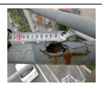
あて板や断面修復などの補修部など で部材表面に凹凸があると、雨水が 滞留したり、施工不良による部材の 隙間から雨水が内部に浸入すること で局部で腐食が進行することがあ であったの腐食では外観に変し が現れた時点で板厚が大きく減少し ていることもある。
