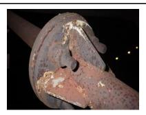
塗装やめっきなどの防食被膜が広く 喪失して腐食が拡がっている場合, 確認時点で板厚減少は軽微でも、腐 食は着実に進展していくことととなる。異常腐食や防食被膜の喪失に る。異常腐食が食被膜の喪失に をった原因によっては、放置すると 急速に腐食が進行する場合もある。
