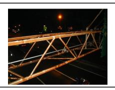
横梁部は、構造によっては風による 振動や腐食による断面減少などで亀 裂が生じやすく、部材の破断が生じ ると第三者被害に至る危険性もあり 注意が必要である。断面減少はほと んど生じていない場合でも、顕著な 腐食が生じると錆片などの落下の危 険性もある。
