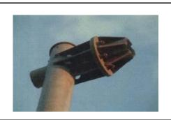
横梁基部が亀裂により破断して落下 した例。
