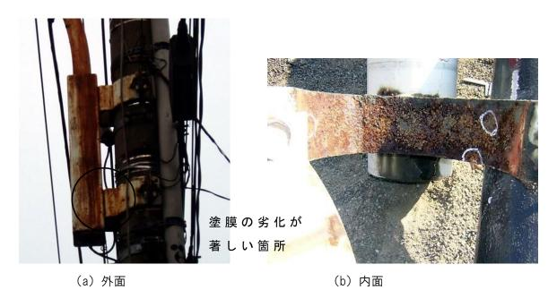
図一8 共架型バンド部における塗膜の劣化例
