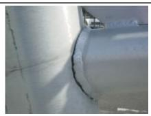
部材格点の溶接部は構造的に溶接品質が確保しにくく、大きな応力振幅が生じやすいため亀裂が生じやすい。その一方で格点部での断面欠損は構造安全性への影響も深刻化しやすい。なお、溶接部では車両衝突の衝撃的な作用の影響によって亀刻が生じることもある。
