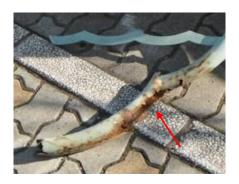
デザイン式などの形状に特徴がある場合には、分岐部やキャップなどの 異常からの水の浸入により、横梁部分や支柱基部の内部で滞水が生じる ことがある。
