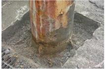
地際部では滞水や塵埃の堆積などが 生じやすく湿潤環境の継続によって 腐食が局部で進行しやすい。地中部 では断面欠損に至っても地表からの 確認が困難な場合があり、地中部で の腐食の疑いがある場合には確認を 検討することも重要である。
