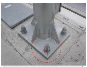
合いマークが見えやすく,かつ,ボルト,ナット,プレートに連続して施工されている。
