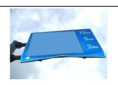
車両接触等の影響により標識板が変 形している例。
