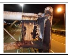
顕著な腐食が広範囲に発生している場合、局部的には大きく板厚が減少していたり断面欠損や亀裂が生じいる可能性がある。なお、錆の上からでは断面減少量や亀裂有無の確認は困難であり、溶接部など応力集中部では特に構造安全性の観点から注意が必要である。
