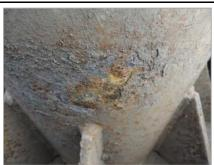
耐候性鋼材の異常さびの発生や、 装やめっきなどの防食被膜が広く喪 失して腐食が拡がっている場合、確 認時点で板厚減少は軽微でも、腐食 は着実に進展していくこととなる。 異常腐食や防食被膜の喪失に至った 原因によっては、放置すると急速に 腐食が進行する場合もある。
