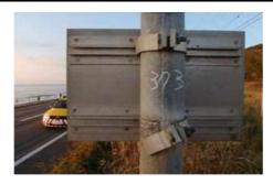
標識板の取付部材が破断、脱落して
