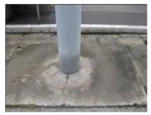
基礎コンクリート部のひびわれは, 内部への雨水の浸透が想定される。 湿潤環境が継続しやすい地中部 際では部分的に著しく腐食し, 好損を生じたり亀裂の発生に至ることがある。また柱基部は, 風や自動 車の通行などにより応力変動が繰り 返され疲労損傷を生じやすい部位で もある。
