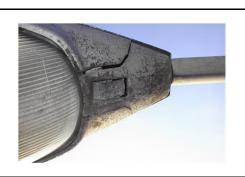
灯具に亀裂が発生している例。 灯具の取付部などに亀裂が生じ ると荷重が支持できず、灯具や その取付部が落下する可能性が ある。
