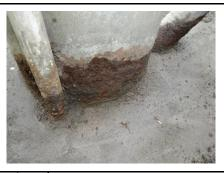
柱基部の局部で板厚減少を伴う腐食 が進行している場合、柱としての耐 荷力が低下して、風等の作用により 座屈や倒壊のおそれもある。また腐 食部から疲労亀裂が進展して倒壊に 至る危険性もある。
