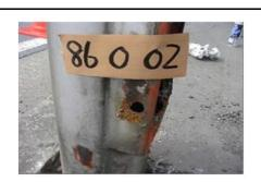
経年劣化及び雨水等の滞水により断面欠損を伴う腐食が生じている例。 開口部からの水の浸入により、支柱 本体の板厚減少を生じさせるおそれがある。
