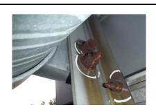
標識板等の取り付け部では、異種金属接触による異常腐食を生じたり、湿潤環境の影響で腐食が進行することがある。またボルトそのものが様々な理由で緩みを生じることがあり、合いマークなどで確認するのが良い。
