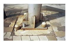
局部的に腐食が生じている場合、確 認時点では耐荷力への影響が限定的 であっても、原因によっては腐食が 進行する可能性もあり、今後耐荷力 へ影響を及ぼす可能性もある。
