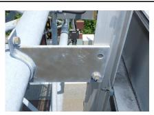
取付部のボルトが抜け落ちている場 合,取付部の機能が低下しており, 標識板が落下するおそれがある。
