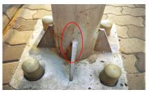
支柱基部のリブ溶接部などでは、揺 れや振動により亀裂が生じることが あり、支柱本体に進展した場合に は、支柱の破断、倒壊が生じるおそ れがある。
