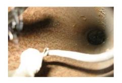
支柱内部に滞水の形跡がある場合, 地中部で基部構造が著しく腐食して いることもある。また, 雨水の浸入 経路によっては今後も滞水が生じる 危険性もあるため原因を明らかにす ることも重要である。
