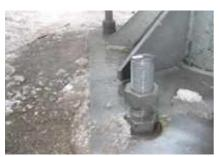
風等による揺れ,振動の影響を受け,アンカーボルト・ナットにゆるみが発生している場合,放置しておくと脱落するおそれがある。
