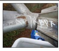
溶接部に局部的な腐食が発生してい る場合、原因によっては放置すると 急速に腐食が進行する場合もある。 また、腐食部では亀裂が発生してい ることがあるため注意が必要であ る。なお、亀裂の有無の確認では錆 を除去することが重要である。
