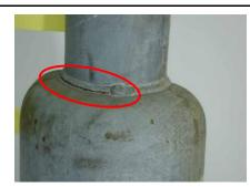
溶接部は部位によらず応力集中箇所となりやすいが、特に部材断面変化部では応力集中に起因して疲労亀裂が生じやすいため注意が必要である。溶接部ではビードの凹凸や塗装やめっきの存在によって亀裂が視認やにくいことも多いことに注意が必要である。
