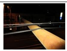
原因を確認すると共に、適切な離隔を確保しなければ、今後の作用によって占用物件、標識の双方に変状が生じる可能性がある。
