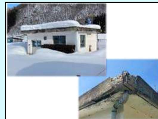
旧建屋の外観と屋根部の破損状況
