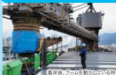
着岸後、ブームを動かしている時
