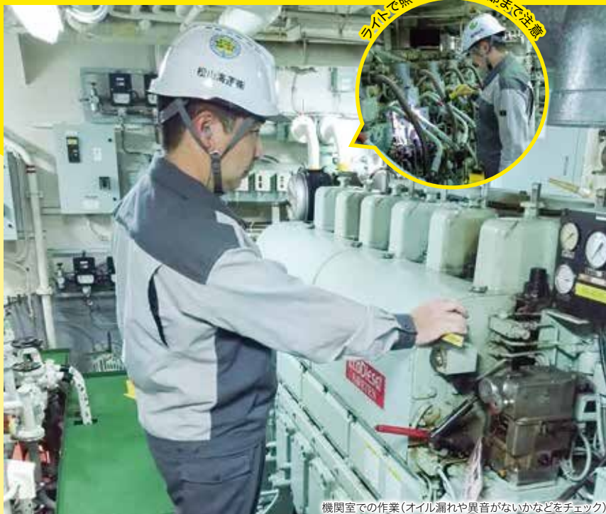
機関室での作業（オイル漏れや異音がないかなどをチェック）
