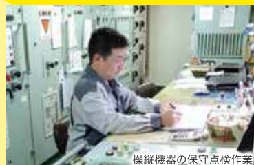
操縦機器の保守点検作業
