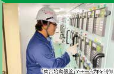
「集合始動器盤」でモータ群を制御
