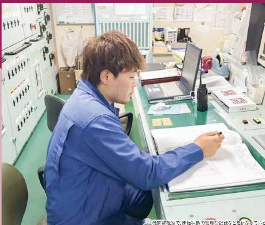
機関監視室で、運転状態の管理や記録などを行なっている
