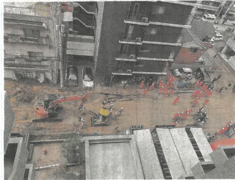
倒壊した住宅から3人が発見された後の土砂崩れ現場 11月13日午後、松山市緑町1丁目(住民提供)
