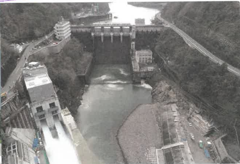
↑ ⑧ 鹿野川ダム（重力式コンクリートダム）
