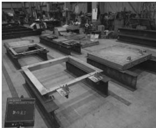
水門製作工 製作完了
