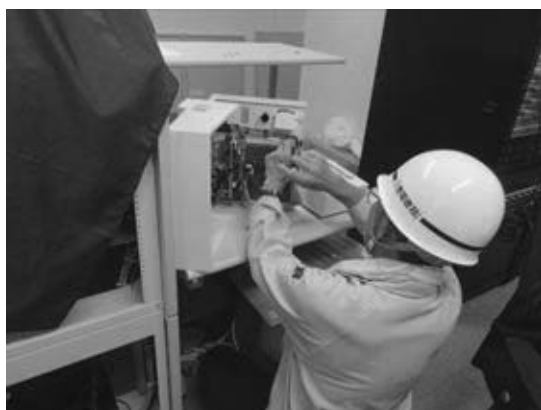
時計修繕_45 分計操作卓基板 作業状況
