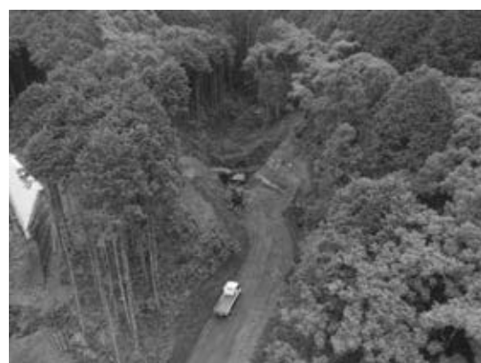
コンクリート堰堤本体工（本村 2 堰堤掘削）
