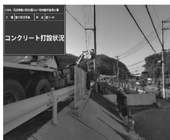
(主) 伊予松山港線_松山市別府町_除草+除草シート or コンクリート打設
