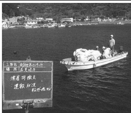
石見海岸 海岸漂着物撤去工 漂着物運搬状況
