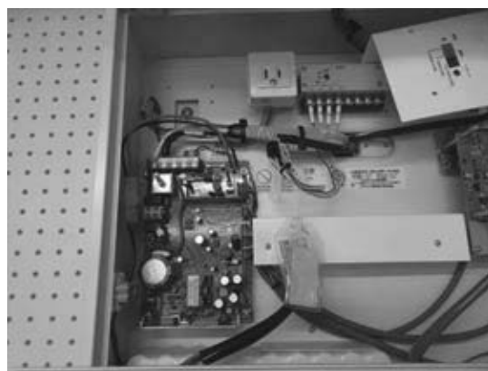
時計修繕_ラジコンユニット 交換済み
