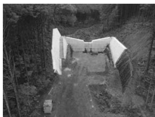
管理用道路工、溪流保全工（山留ブロック積）
