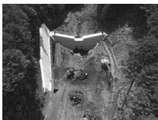
管理用道路工、溪流保全工（山留ブロック積）掘削
