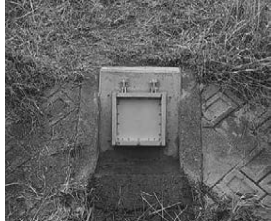
フラップゲート交換完了
