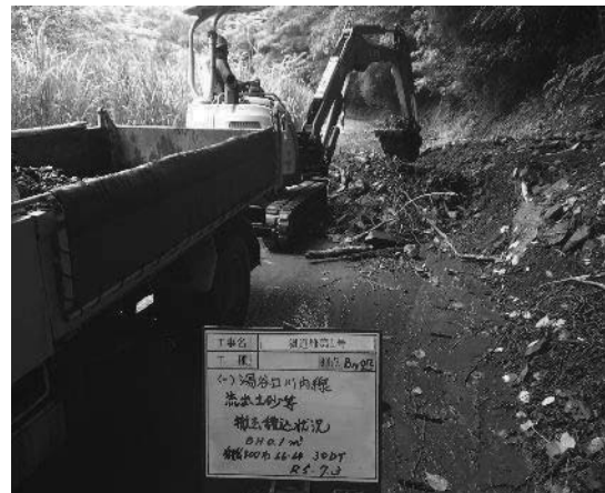
(一) 湯谷口川内線_東温市則之内~松瀬川_崩土及び倒木除去
