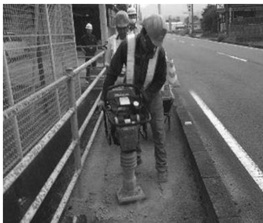
(主) 伊予川内線_松山市中野町_路面陥没補修
