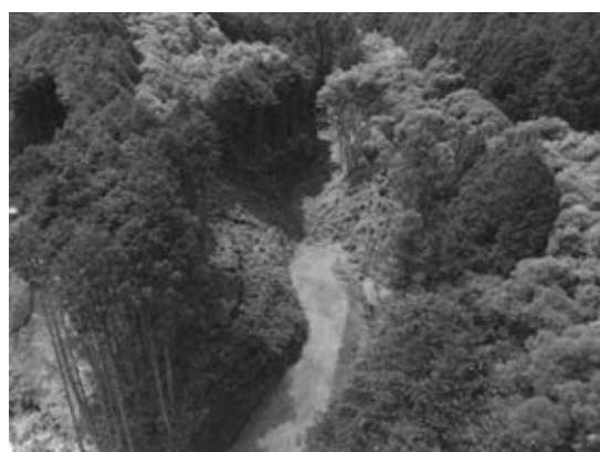
コンクリート堰堤本体工（本村 2 堰堤掘削前）
