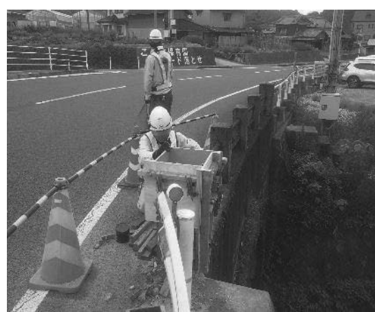
(主) 松山北条線_松山市下伊台町_屋敷橋補修
