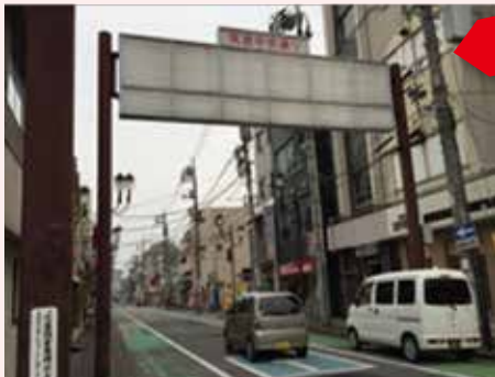
撤去されずに残されたアーチ看板
