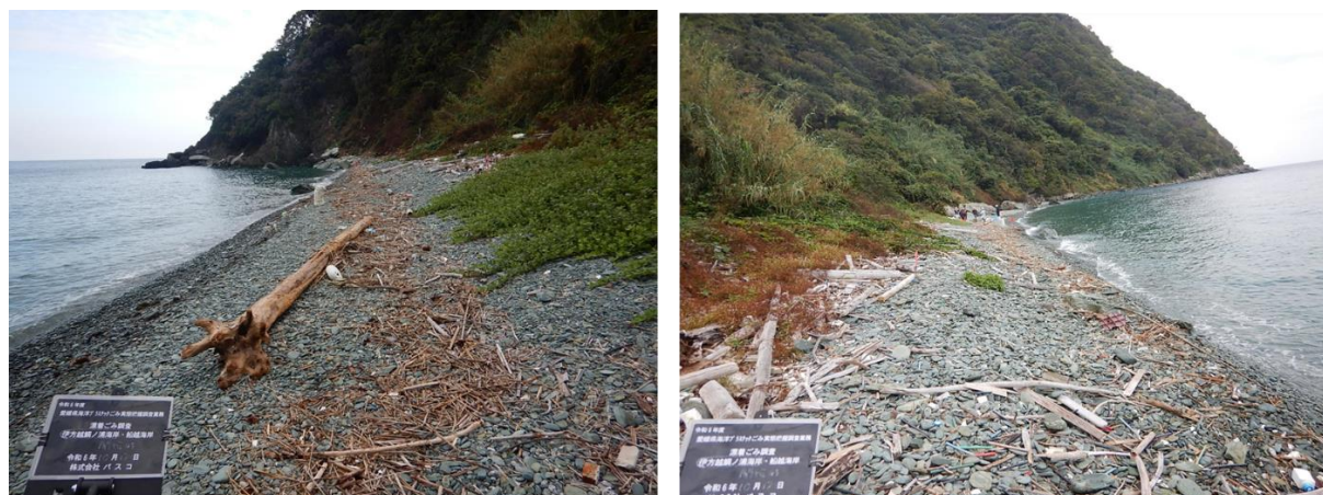
写真 2-3-1(1) 調査地点の状況(伊方越鯛ノ浦海岸)
