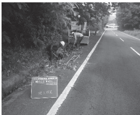
(一) 栗井浅海線_松山市上難波_側溝清掃
