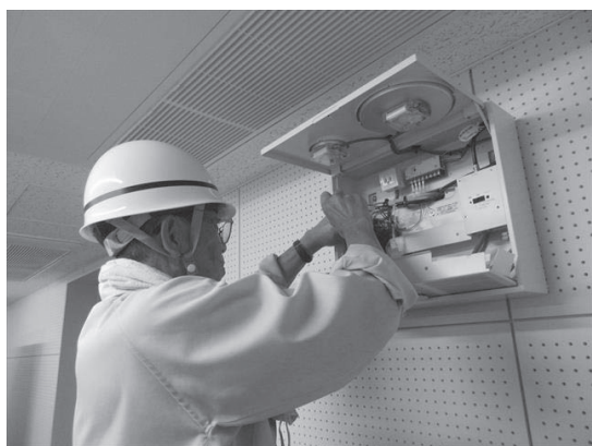
時計修繕_ラジコンユニット 作業状況
