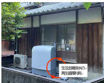
既存住宅の外に設置（配管接続工事）
