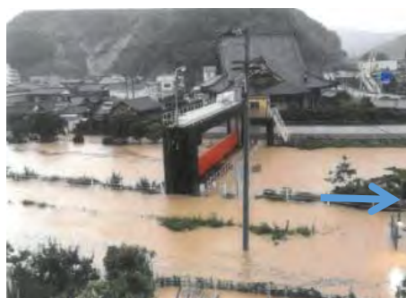
(二) 立間川水系河内川(宇和島市)
