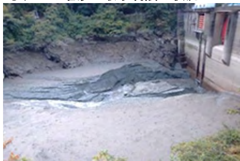
鹿森ダム（新居浜市）堆砂状況
