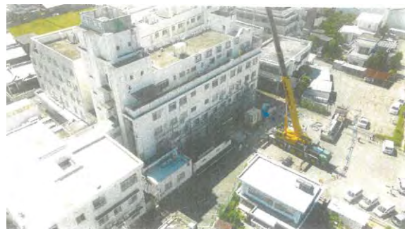
＜医療機関の耐震化工事＞
