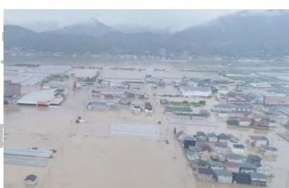
○西日本豪雨災害の被災状況（大洲市）
