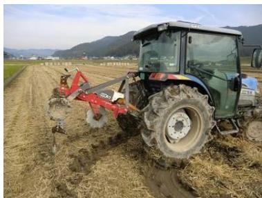
写真 弾丸暗きょ施工
