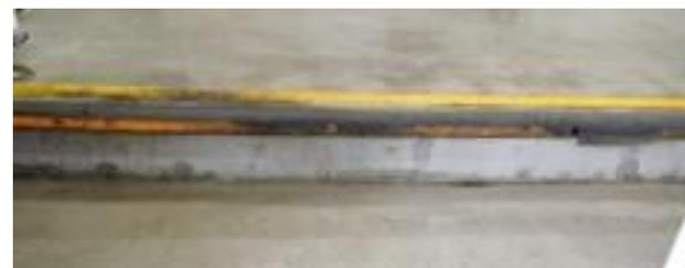
■ コンクリートのはげ、荷受けのプラットフォームのゴムが劣化など、施設の老朽化が見られた。長期間、放置しないよう補修や交換のルールを明確にする必要がある。
