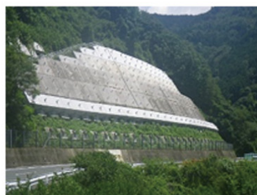
法面防災対策(アンカー工)
