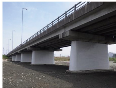
橋梁耐震対策(橋脚巻立工)
