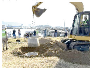
マンホール撤去
