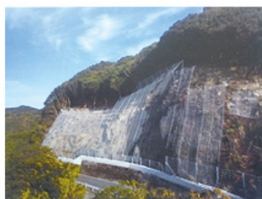
法面防災対策(落石防護工)
