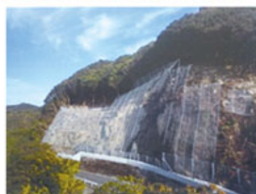
法面防災対策(落石防護工)
