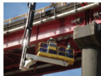
【橋梁点検車による定期点検】
