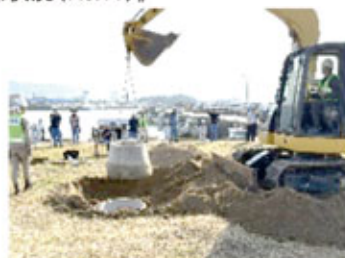
マンホール撤去
