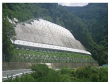
法面防災対策(アンカー工)
