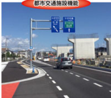
松山外環状道路空港線【松山市】
