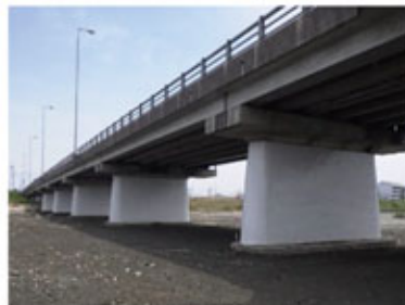
橋梁耐震対策(橋脚巻立工)
