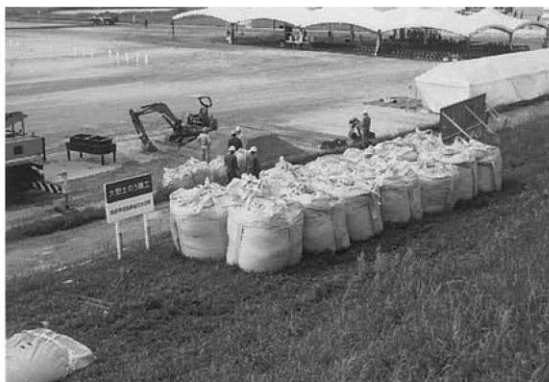
(大型土のう工)
