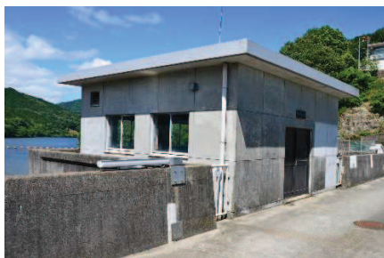
取水ゲート操作室
