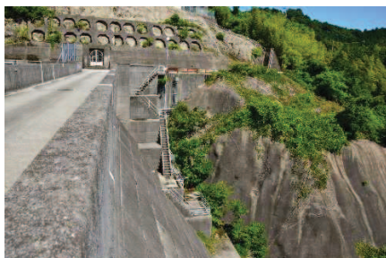
管理用階段通路
