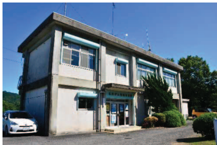
ダム管理事務所
