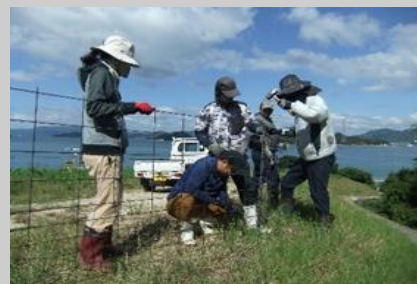
【ワイヤーメッシュ柵の設置実習】
