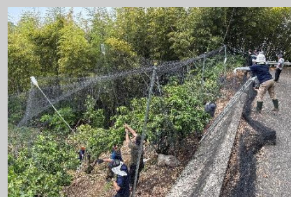
【防鳥施設の設置作業の様子】
