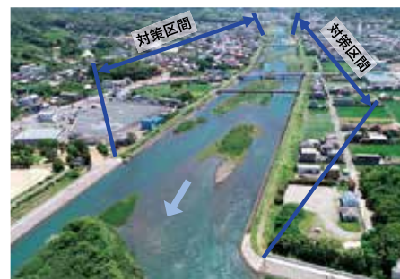
(二) 僧都川（愛南町）堤防耐震対策工事
