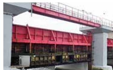
大川水門（松山市）扉体塗替え
