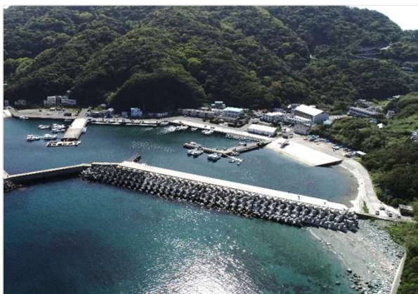
佐田岬漁港における防波堤の耐震・耐津波化 【写真左：全景、写真右：近景】
