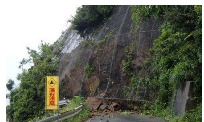
国道378号 (西予市明浜町)
