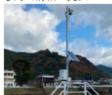
河川監視カメラ
