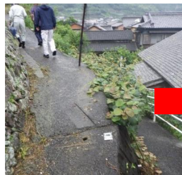
(整備前の避難路)
