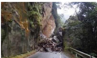
県道西条久万線（西条市中奥）
