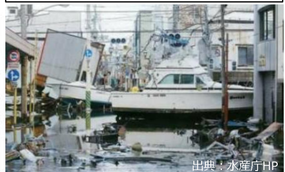
【東予港】放置艇による二次被害の恐れ
