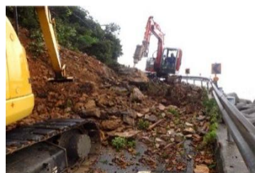
国道378号（西予市三瓶町）
