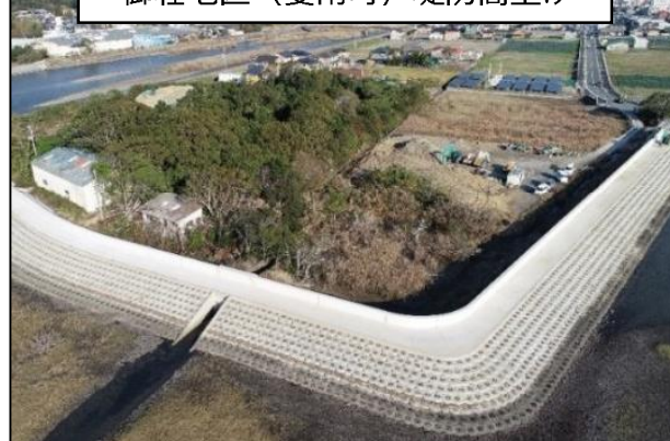
御荘地区（愛南町）堤防嵩上げ
