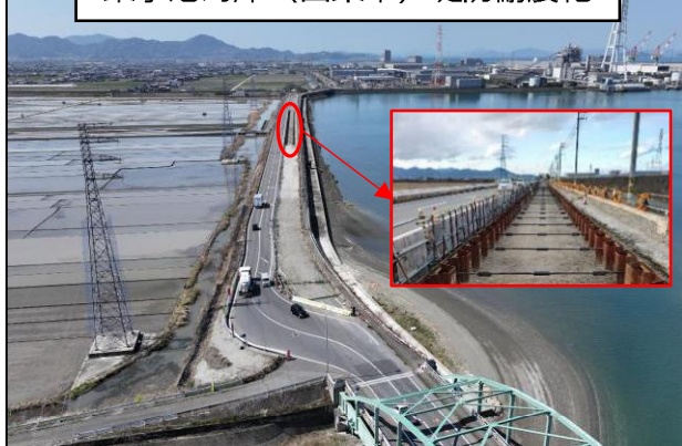
東予港海岸（西条市）堤防耐震化
