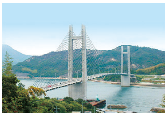
上島架橋（生名橋）
