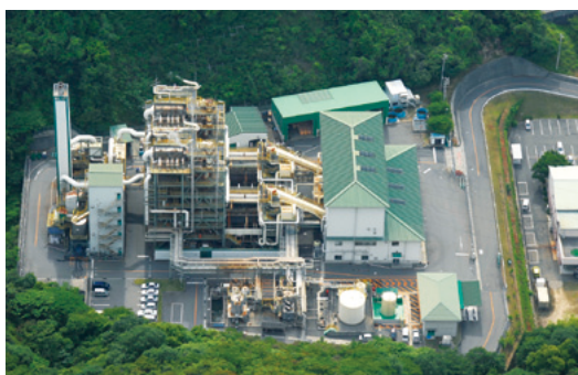
愛媛県廃棄物処理センター
