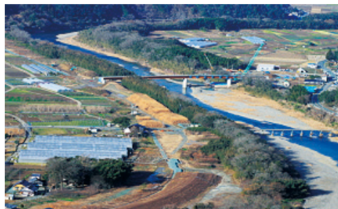
河川改修が進む肱川 (大洲市)
