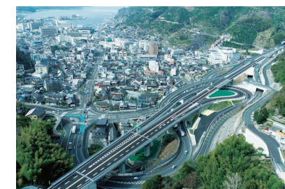
大洲・八幡浜自動車道
