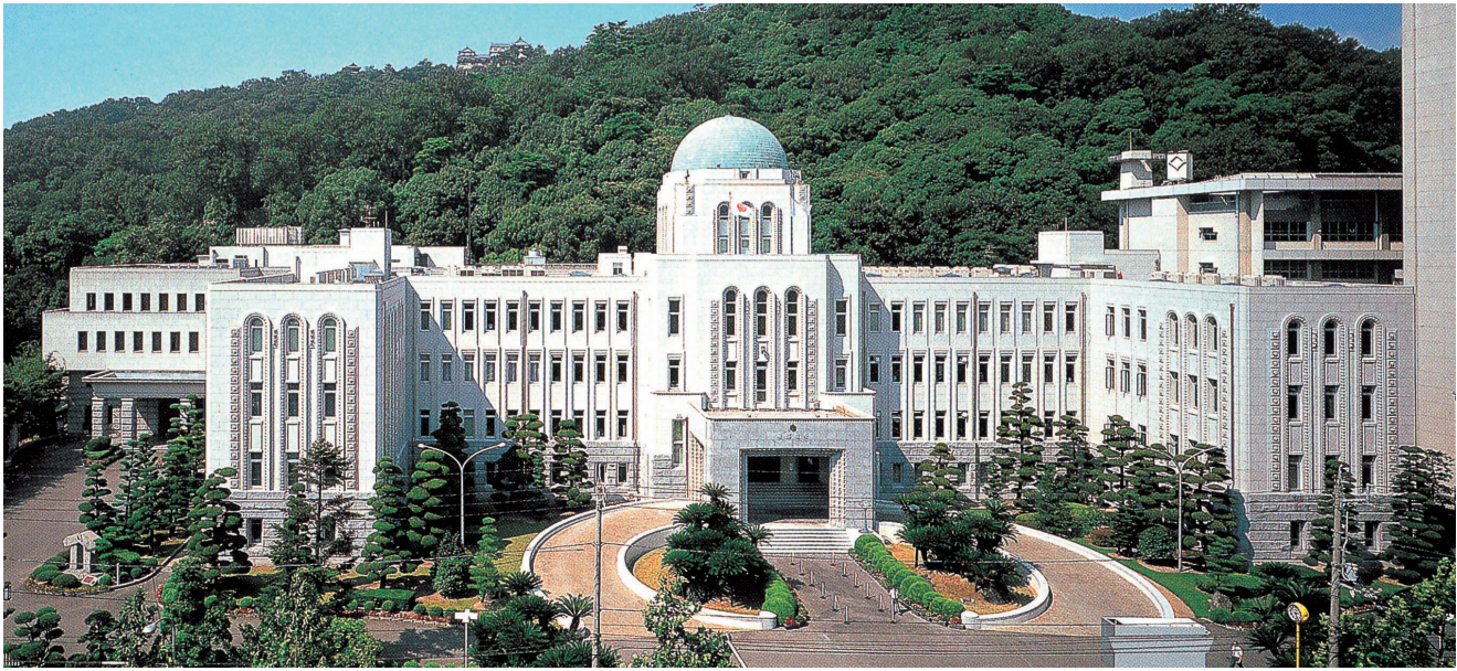
愛媛県庁本館（昭和4年（1929年）2月竣工）
