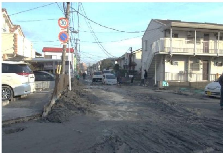
(a) 液状化の被害
