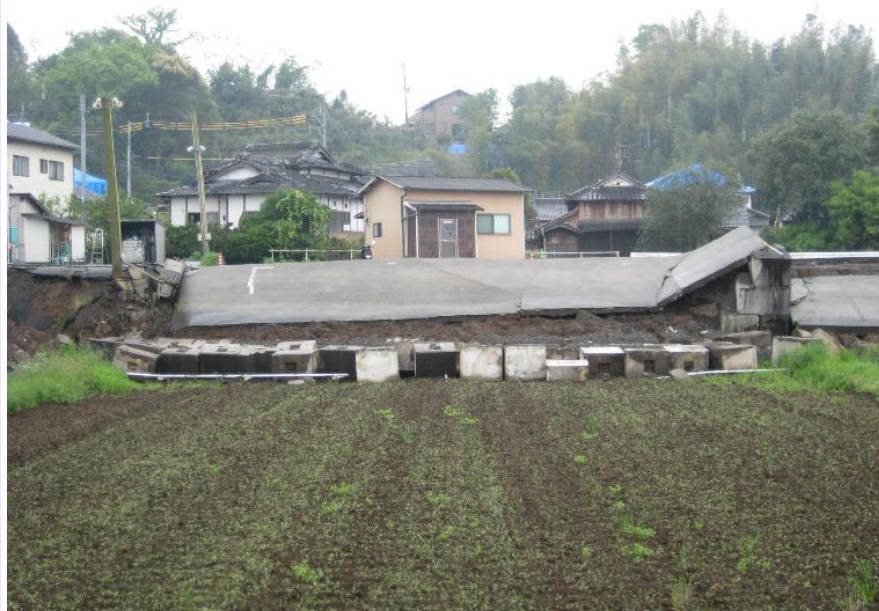
(a) 積みブロック擁壁群の崩壊
