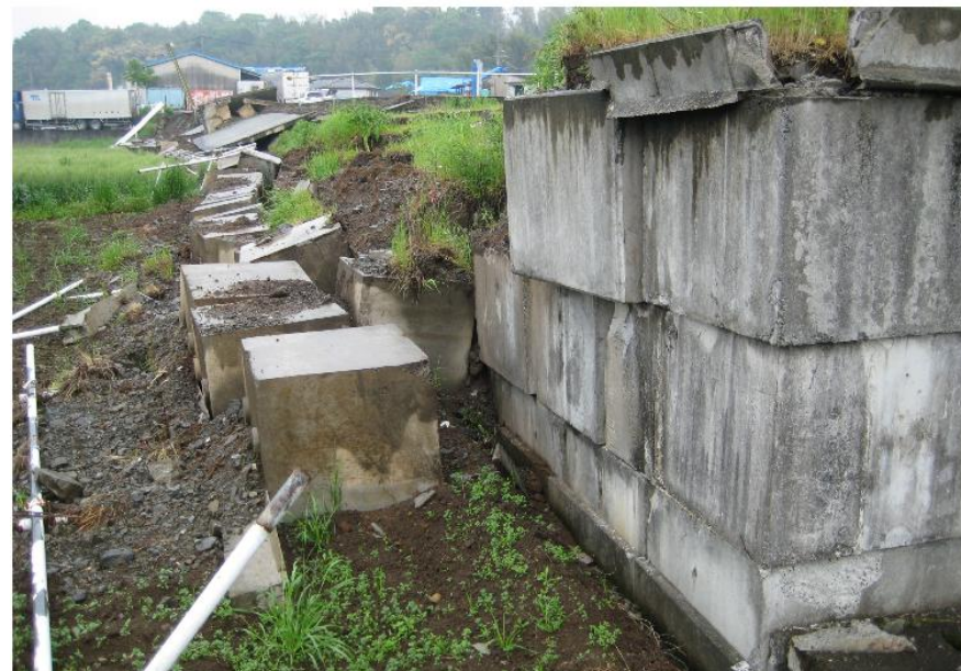
(a) 積みブロック擁壁群の崩壊
