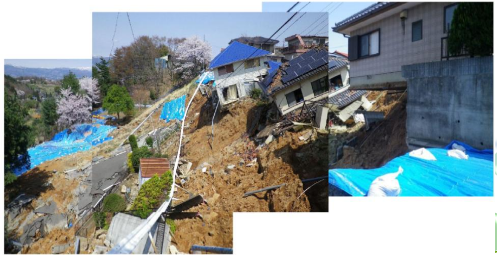
(d)液状化による側方流動の事例
