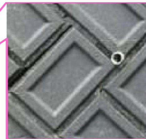
(b) 水抜穴が 20 mm と小さい事例
