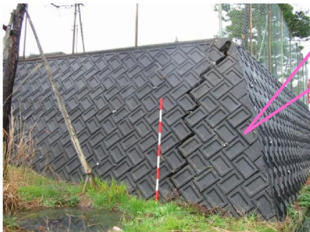
(b) 水抜穴が 20 mm と小さい事例
