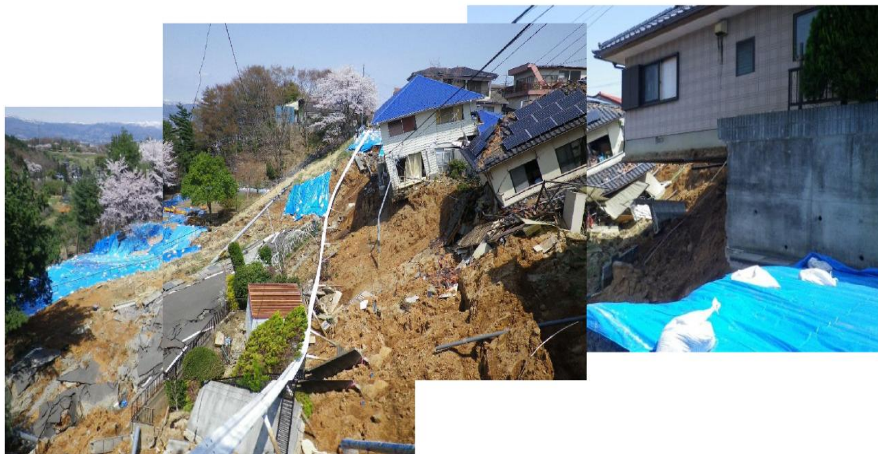
写3-11 のり面の崩壊の例
