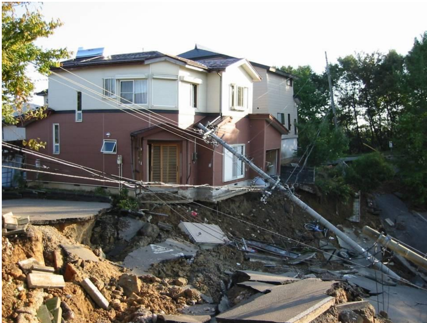
H16新潟県中越地震の被害
