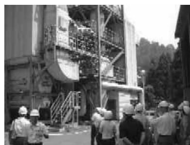
当該施設（エコニックス）にはロータリーキルン式焼却溶融炉が 2 炉設置されている。このロータリーキルン式焼却溶融炉の採用により、多様な廃棄物の焼却溶融一括処理と、溶融スラグの回収が可能になり、また、高温燃焼によるダイオキシンの発生の抑制等、環境にも配慮した構造が採用されている。燃焼エネルギーは熱回収による汚泥乾燥、温水・冷暖房利用等に使われている効率的なシステムとなっている。
