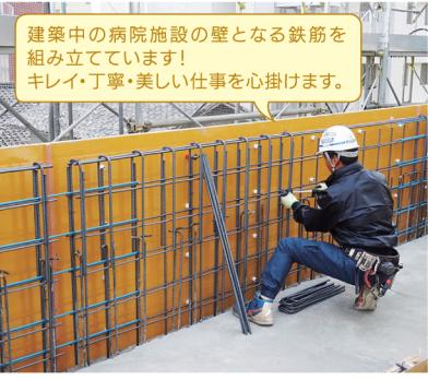
建築中の病院施設の壁となる鉄筋を組み立てています！
