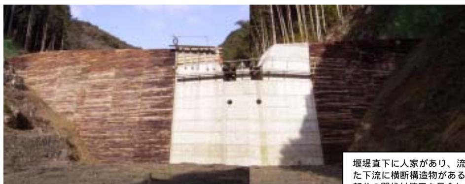
堰堤直下に人家があり、流路断面も狭い。また下流に横断構造物があることから、水通し部分の間伐材使用を見合わせた事例
