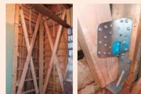
補強例:筋かい追加・接合金物追加
