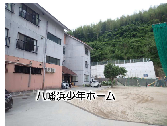
擁壁による要配慮者利用施設の保全(迫田B地区)
