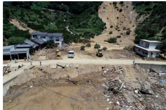
港湾関係(玉津港海岸) 被災時(復旧前)
