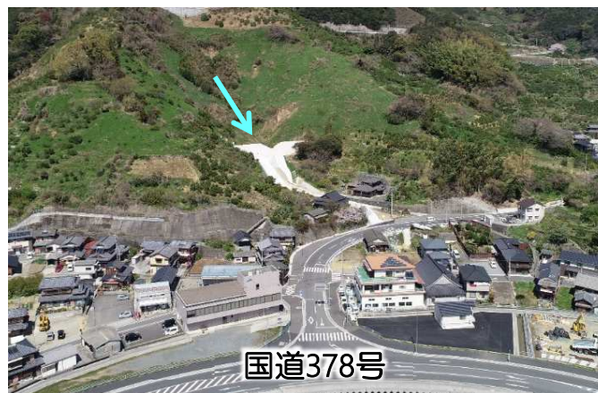
砂防堰堤による重要交通網の保全(脇川)
