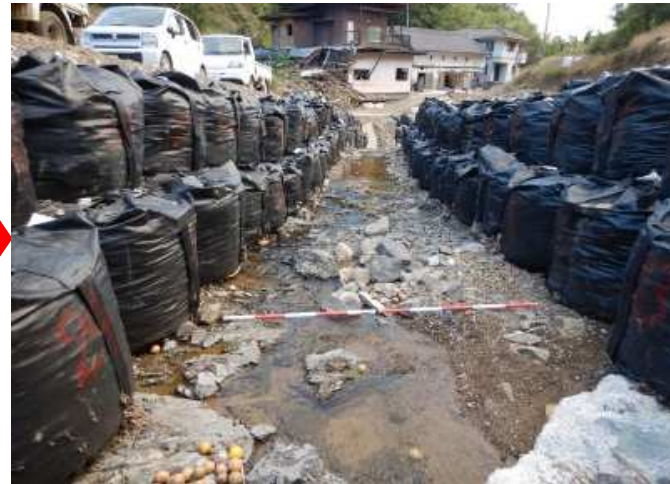
白井谷川) 応急復旧後
