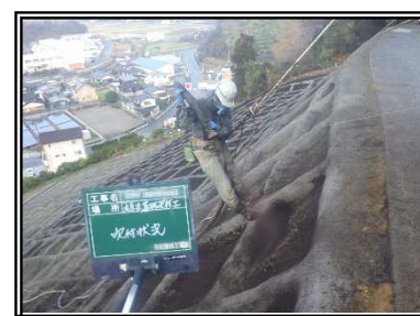
簡易吹付法砕工状況
