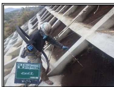
現場吹付法砕工状況
