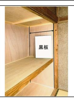
壁補強工事(構造用合板+筋かい)・金物補強工事
