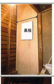
壁補強工事(構造用合板+筋かい)・金物補強工事
