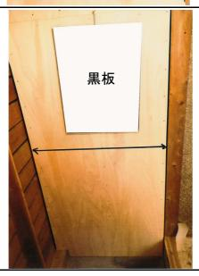
壁補強工事(構造用合板+筋かい)・金物補強工事
