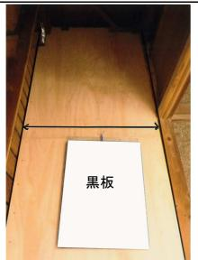
壁補強工事(構造用合板+筋かい)・金物補強工事
