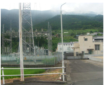
銅山川第三発電所
