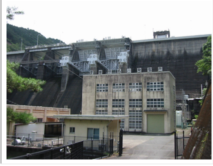
肱川発電所（更新前）
