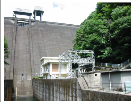
道前道後第一発電所
