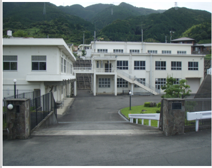
銅山川第一発電所
