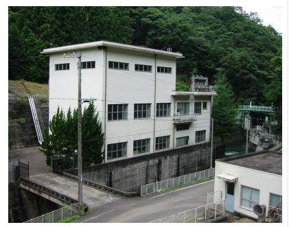
道前道後第二発電所
