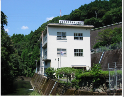
道前道後第三発電所
