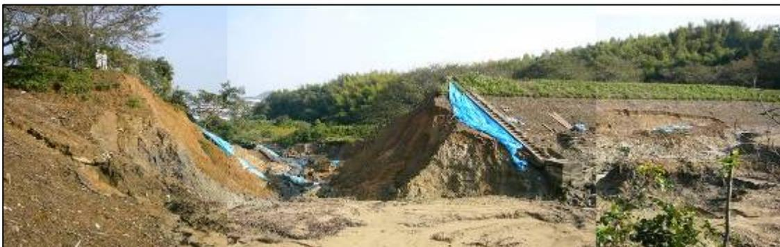
【台風15号(H16.8.18)による堤体の被災状況】
