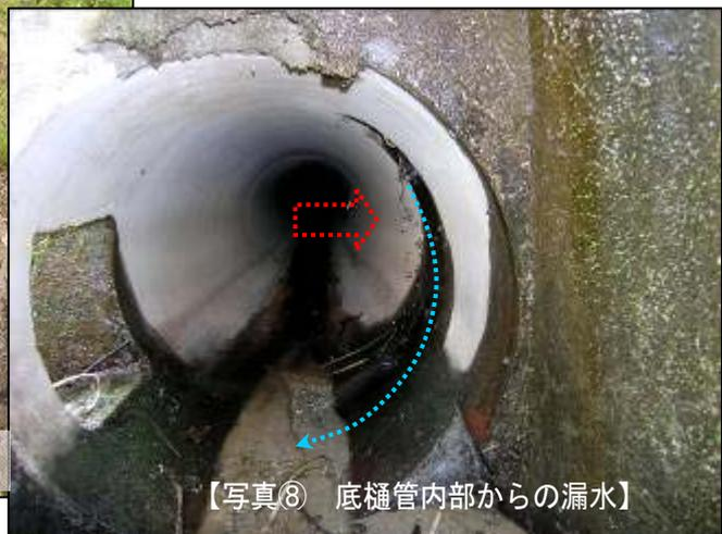
【写真⑧ 底樋管内部からの漏水】
