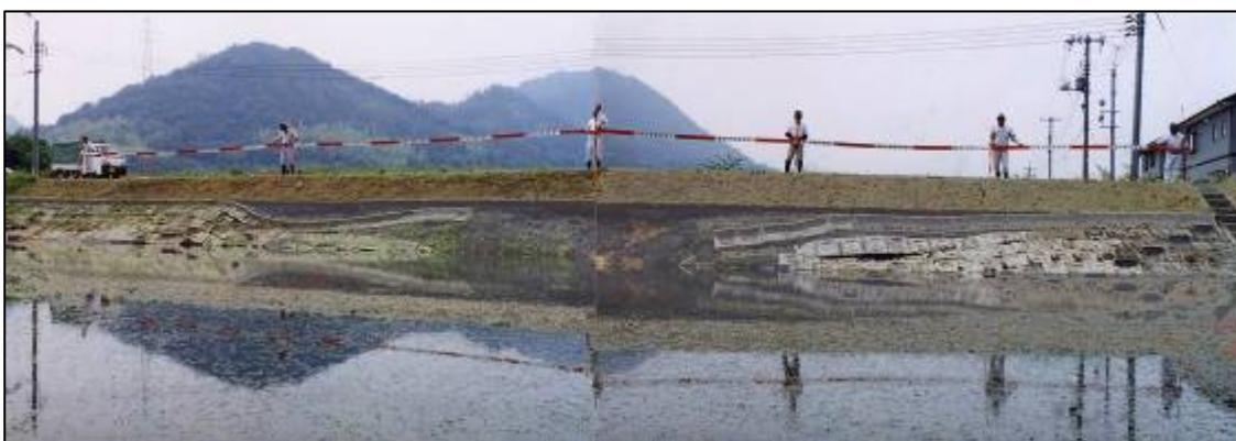
【芸予地震(H13.3.24)による堤体張りブロックの被災状況】
