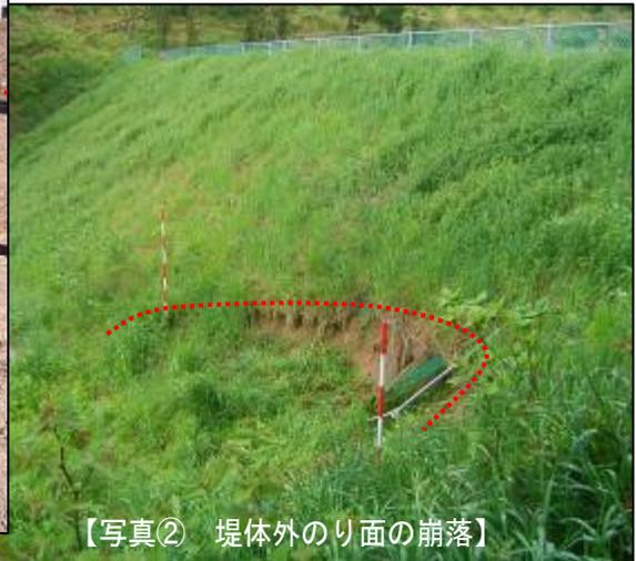
【写真②】 堤体外のり面の崩落
