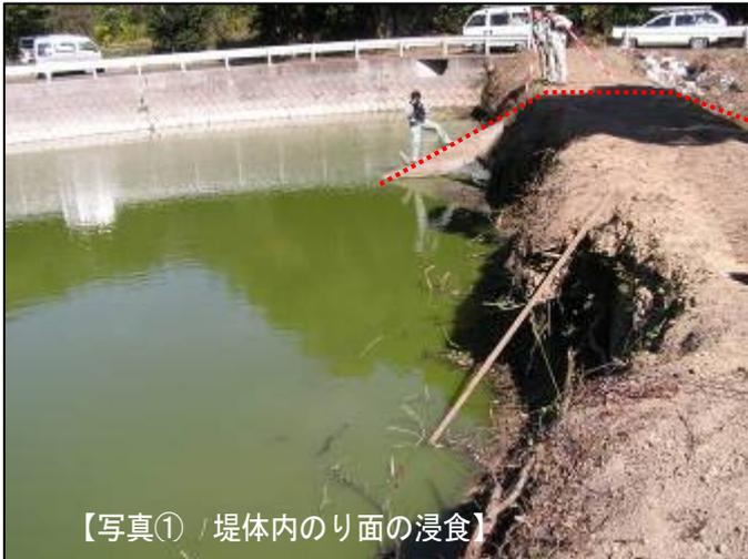
【写真①】 堤体内のり面の浸食
