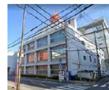
①NTT愛媛ビル2棟
