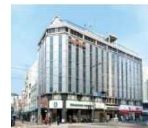
⑤いよてつ会館ビル
