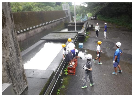
利水放流バルブの見学
