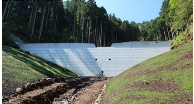
県営治山工事で東温市の湧水地区に「治山ダム」を施工しました。
