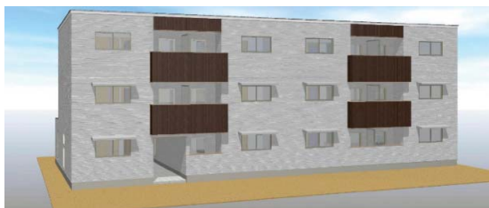
3階建てCLT木造(仮)緑町マンション
