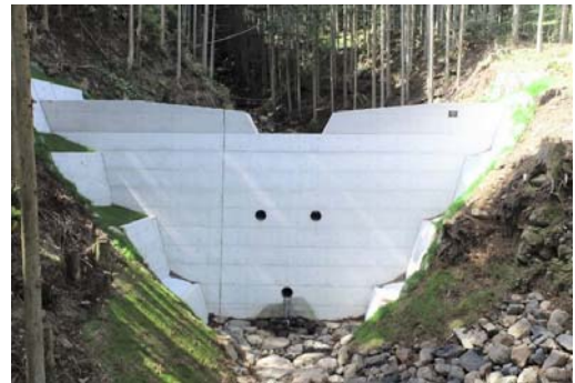
黒岩地区の治山ダム
