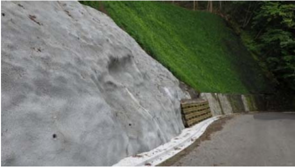
東温市が事業主体で林道「上林河之内線」の改良工事(法面工等)を施工しました。
